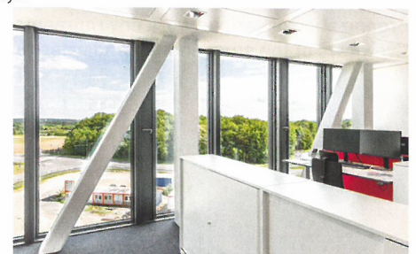
Fassade mit innen liegender Tragstruktur
